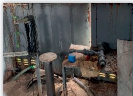
Intérieur du pavillon Surcouf
